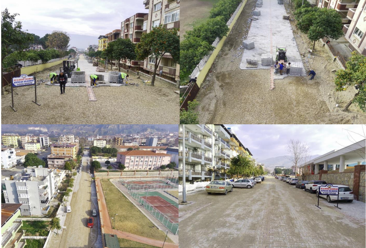
İlçe merkezinde bulunan kaymakam lojmanı kuzeyindeki güneş sokakta beton parke döşemesi yapıldı.
