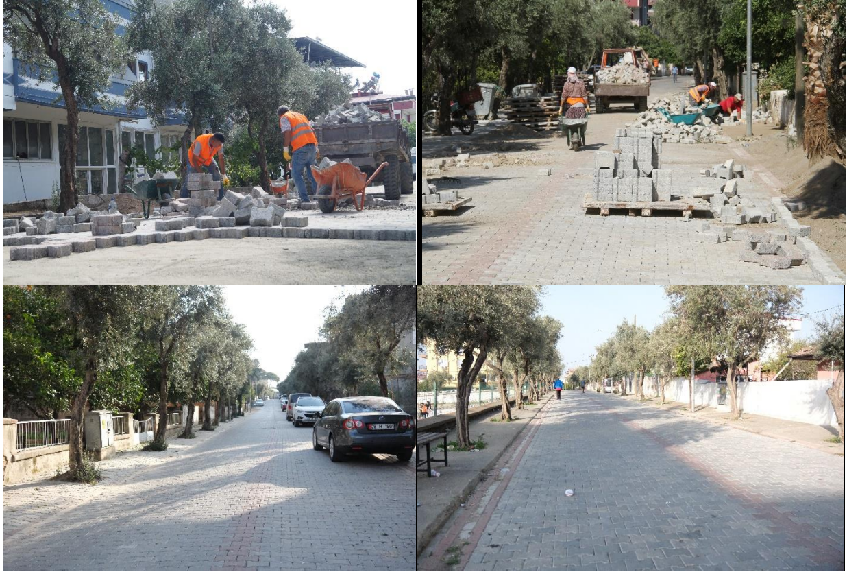
İlçe merkezinde bulunan Cafer ÖZHAN sokakta beton parke çalışması yapıldı.
