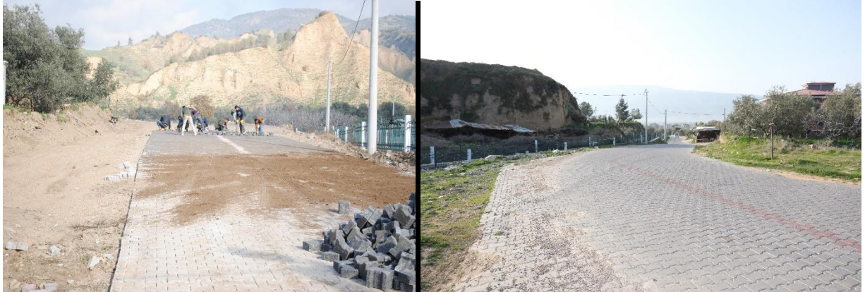
İlçe merkezinde bulunan Toki yoluna beton parke çalışması yapıldı.
