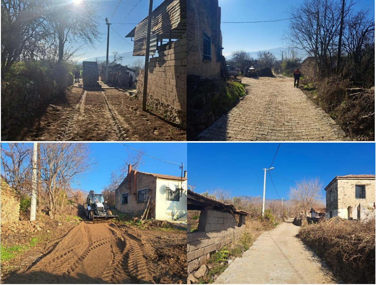
Çobanisa Mahallesi, 1009 Sokak beton parke döşemesi yapıldı.
