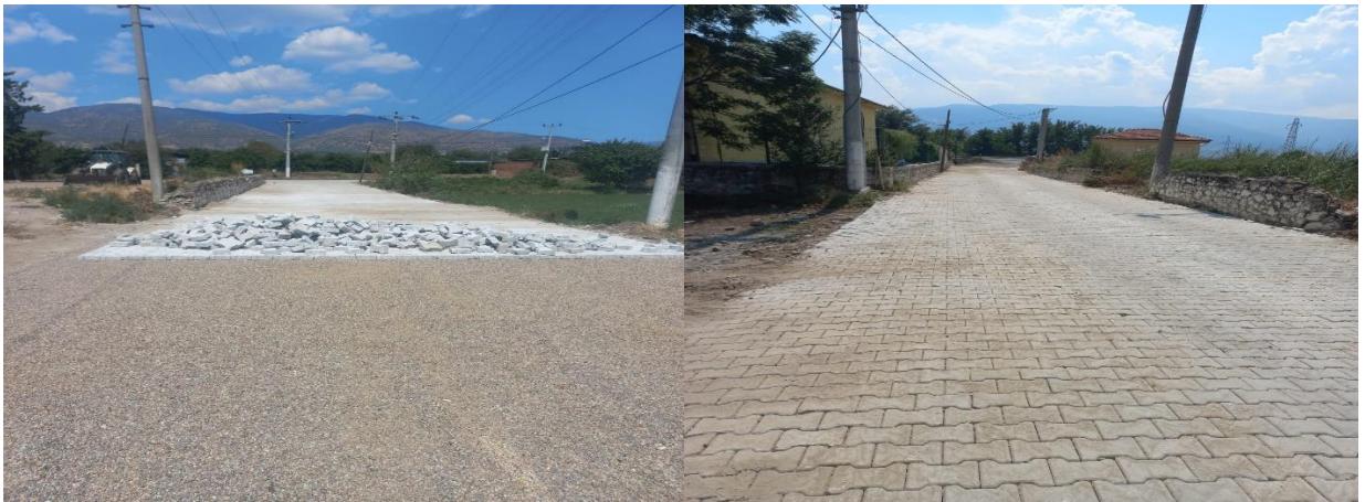
Çobanisa Mahallesi, 1005 Sokak beton parke döşemesi yapıldı.
