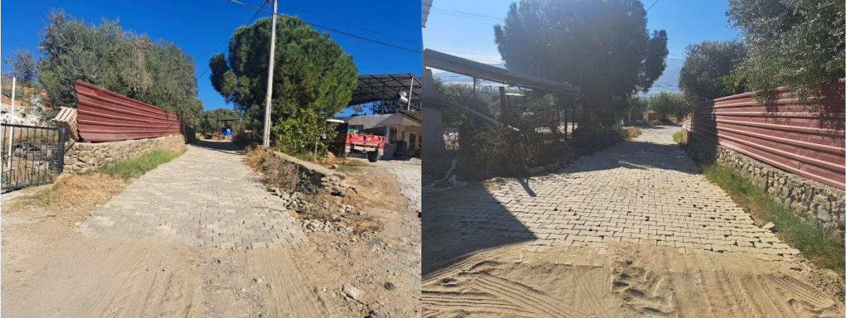
Çobanisa Mahallesi, 1004-1 Sokak beton parke döşemesi yapıldı.
