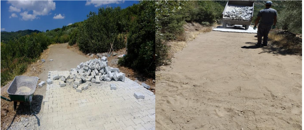
Kayran Mahallesi beton parke döşemesi yapıldı.
