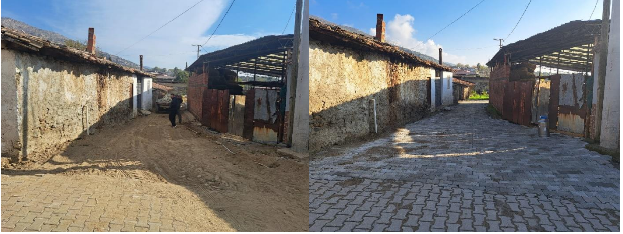
Çobanisa Mahallesi, 1003-1 Sokak beton parke döşemesi yapıldı.
