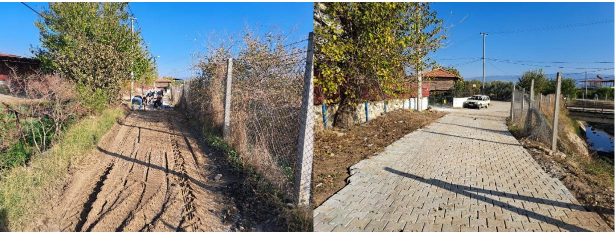
Çobanisa Mahallesi, 1014 Sokak beton parke döşemesi yapıldı.
