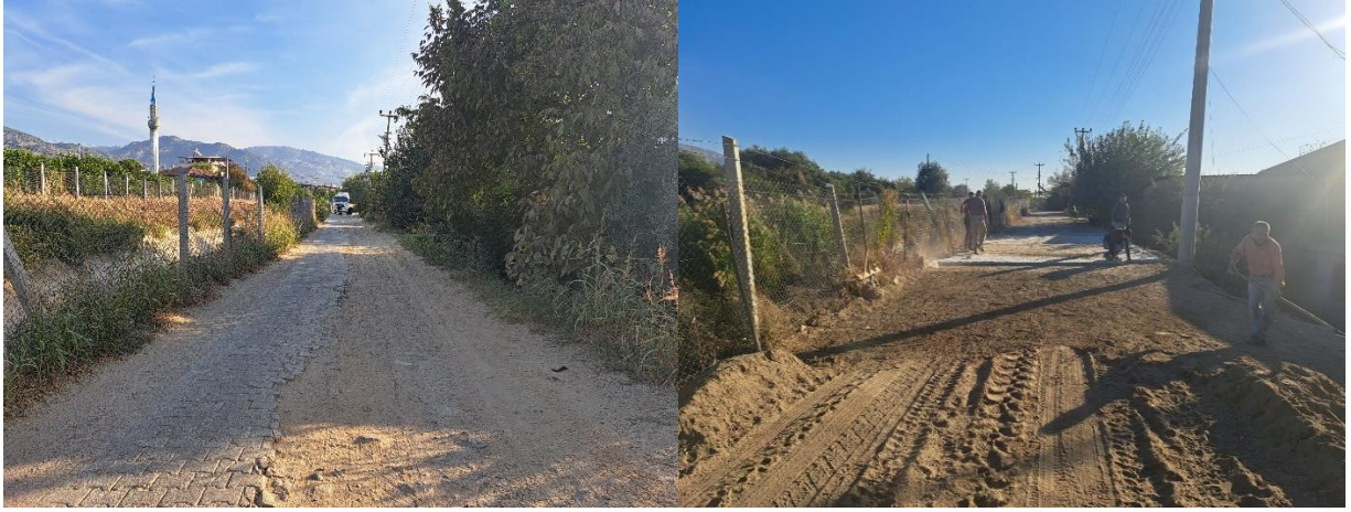
Çobanisa Mahallesi, 1017 Sokak beton parke döşemesi yapıldı.
