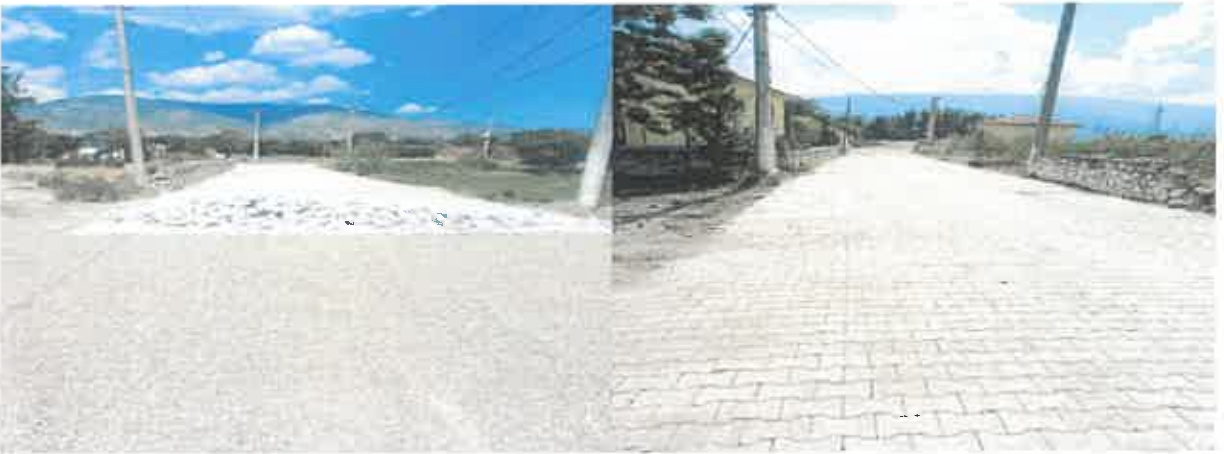
Çobanisa Mahallesi, 1005 Sokak beton parke döşemesi yapıldı.
