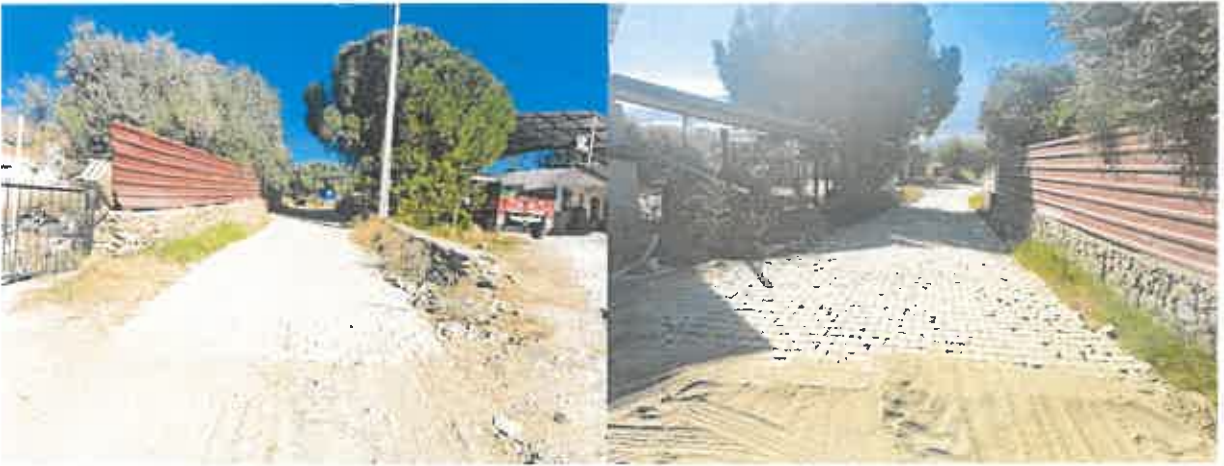
Çobanisa Mahallesi, 1004-1 Sokak beton parke döşemesi yapıldı.
