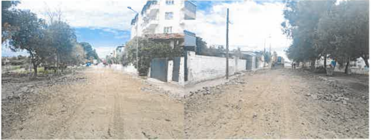
Beşeylül Mahallesi, Seher Sokak beton parke döşemesi yapıldı.
