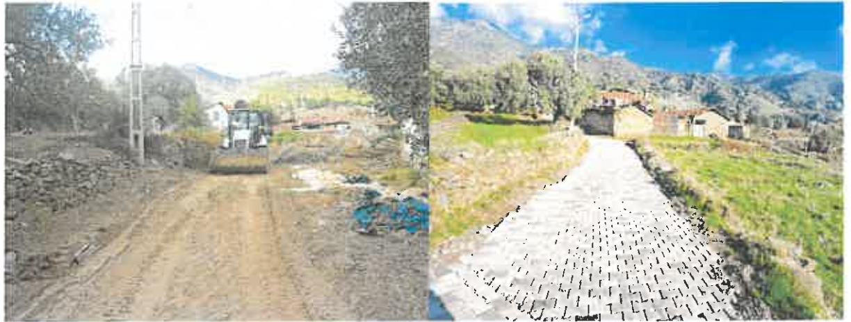
Çobanisa Mahallesi, 1001-2 Sokak beton parke döşemesi yapıldı.
