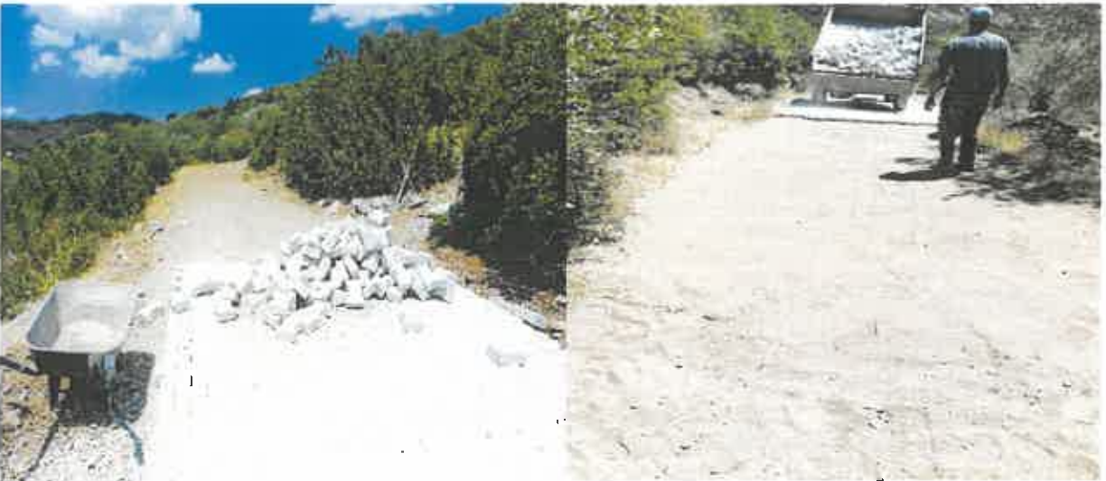
Kayran Mahallesi beton parke döşemesi yapıldı.
