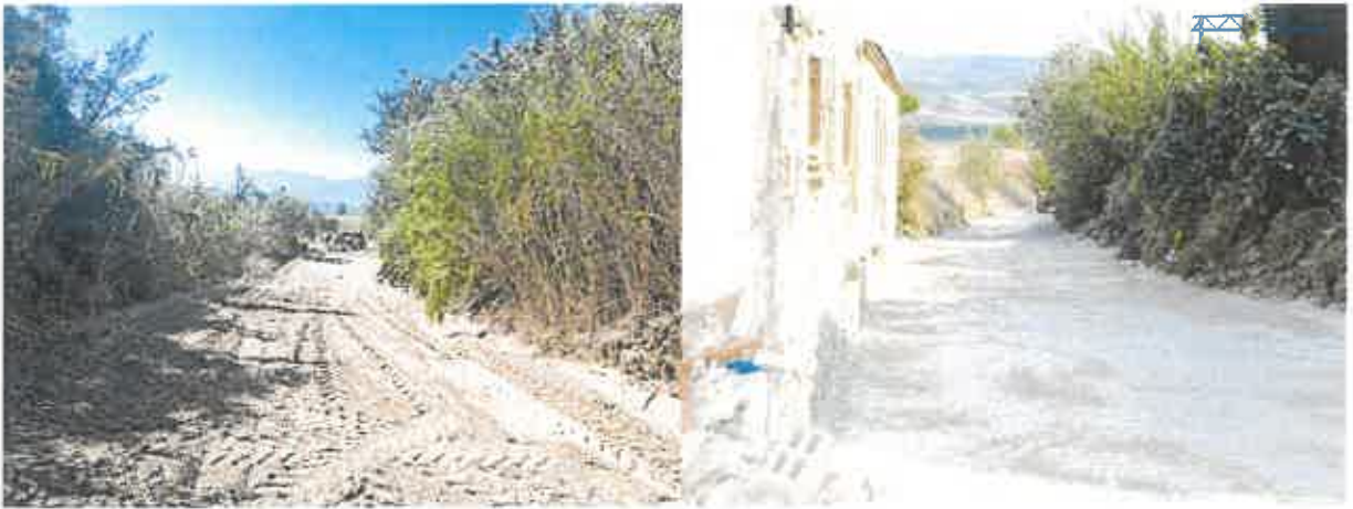
Horsunlu Mahallesi, Eren Sokak beton parke döşemesi yapıldı.
