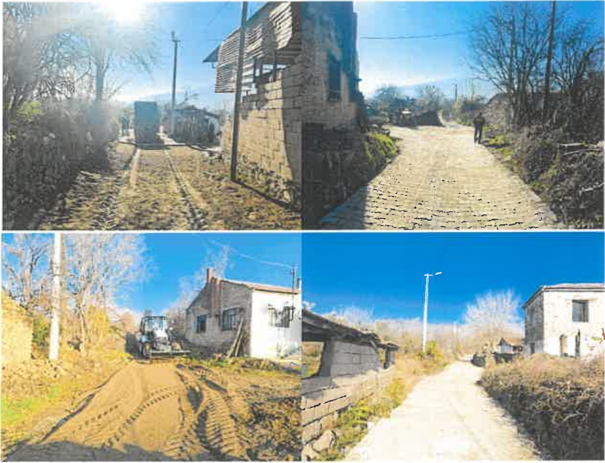
Çobanisa Mahallesi, 1009 Sokak beton parke döşemesi yapıldı.
