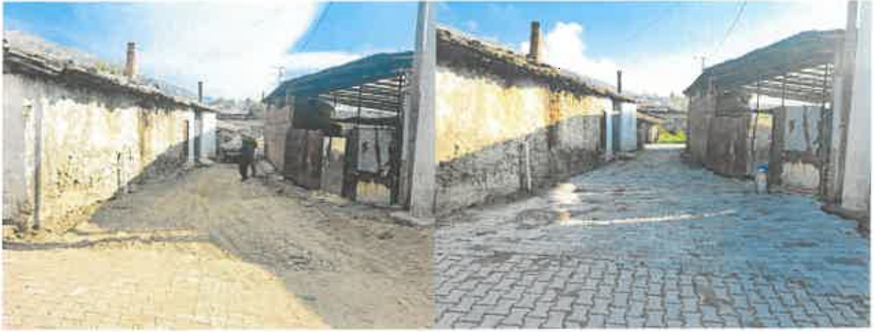
Çobanisa Mahallesi, 1003-1 Sokak beton parke döşemesi yapıldı.
