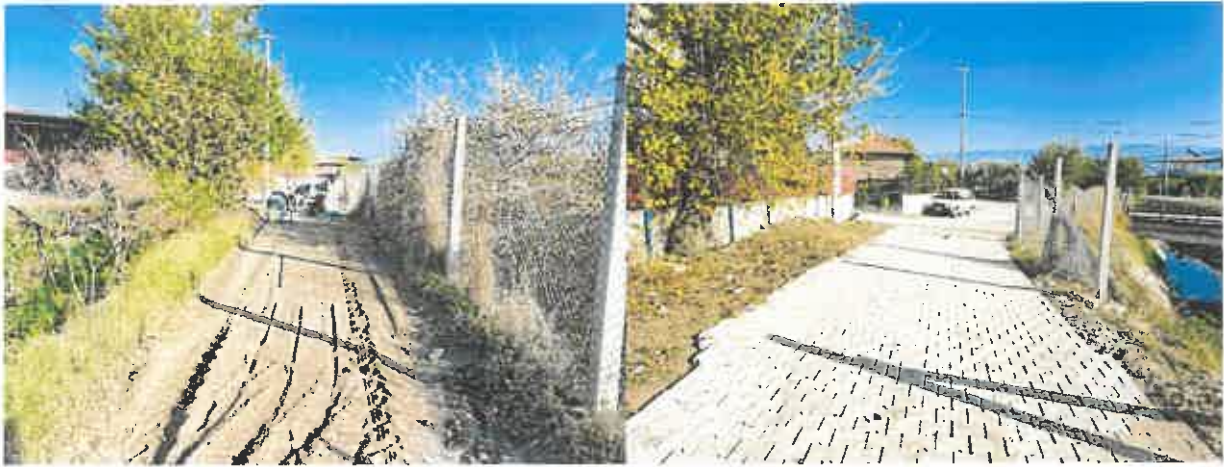
Çobanisa Mahallesi, 1014 Sokak beton parke döşemesi yapıldı.
