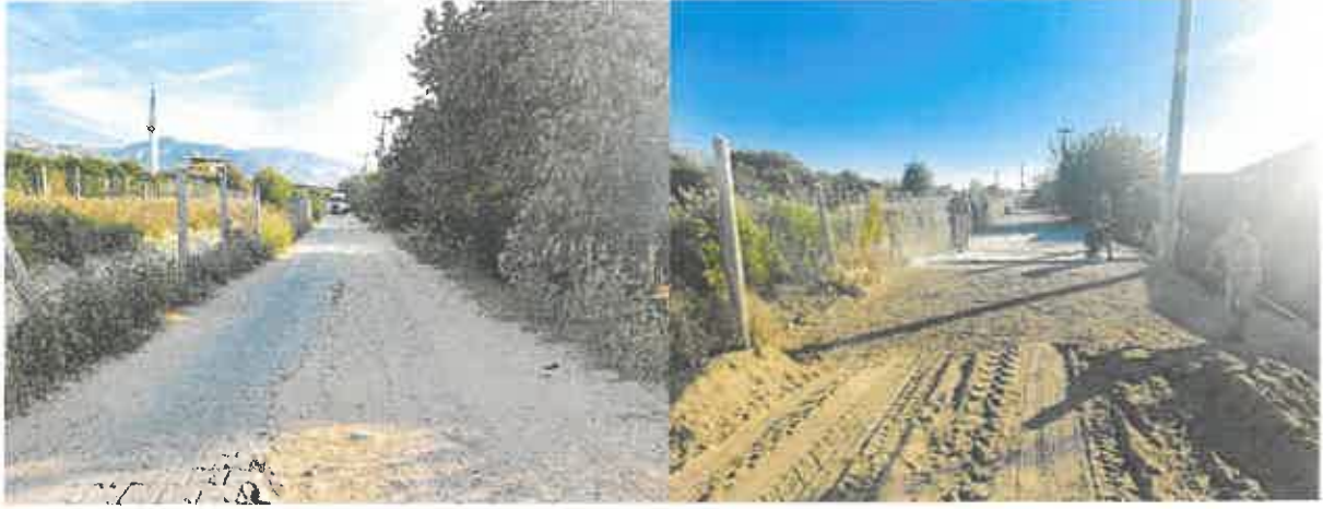
Çobanisa Mahallesi, 1017 Sokak beton parke döşemesi yapıldı.
