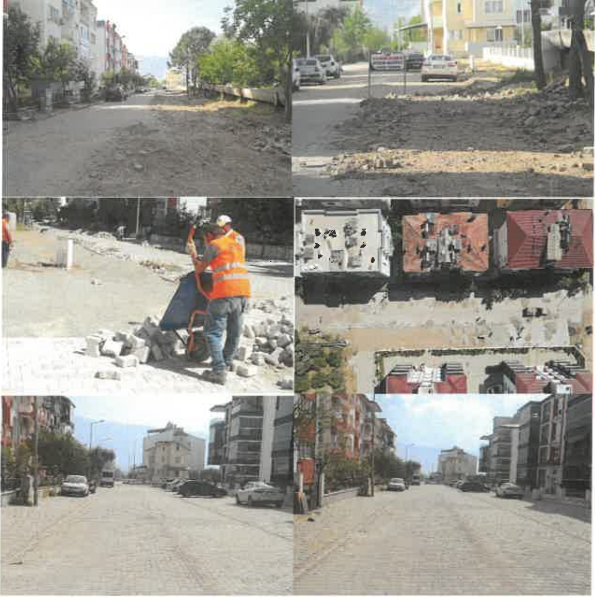
İlçe merkezinde bulunan hürriyet sokakta beton parke çalışması yapıldı.
