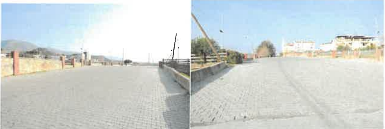
İlçe merkezinde bulunan demiryolu köprüsüne beton parke çalışması yapıldı.
