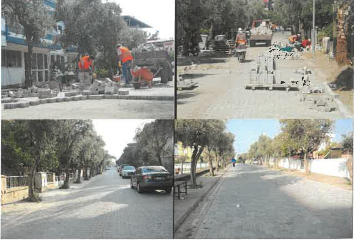
İlçe merkezinde bulunan Gençlik sokakta beton parke döşemesi yapıldı.
