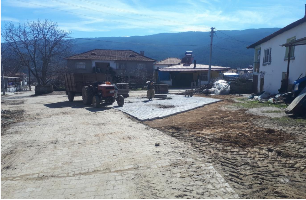
Sarıcaova mahallesi meydan beton parke taşı kaplaması yapıldı.
