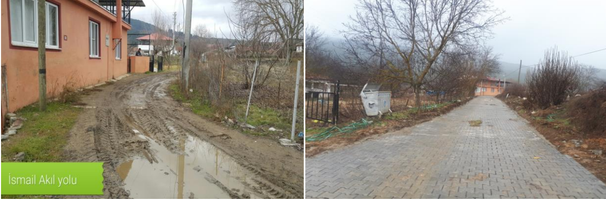
Sarıcaova mahallesi İsmail AKIL sokağı beton parke taş kaplaması yapıldı
