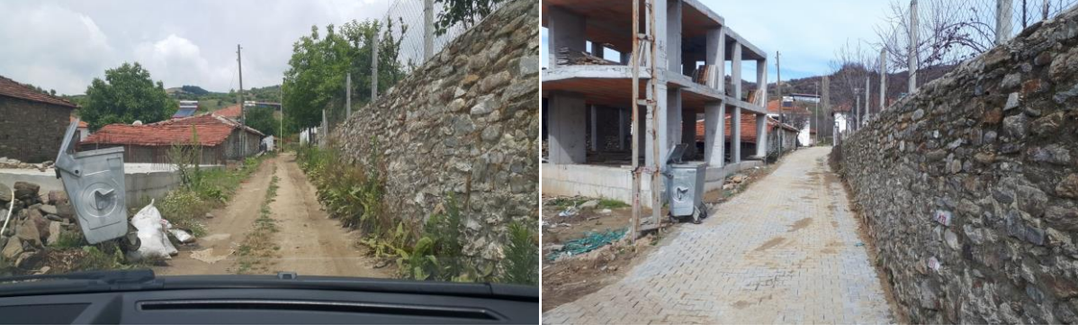
Sarıcaova mahallesi Arif DANAŞ üst sokağı beton parke taşı kaplaması
