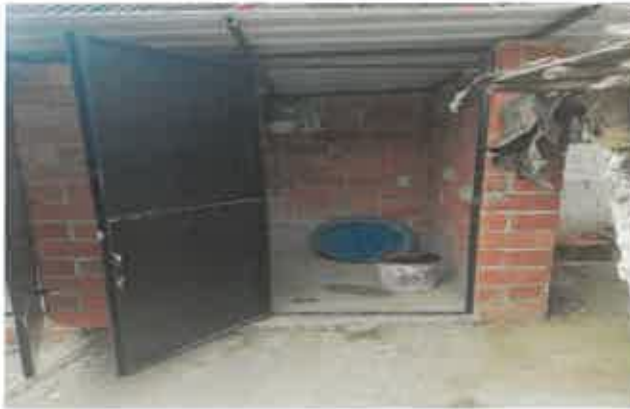
Aydınolu Mh.-Aydın KARABOĞA Wc-Banyo Yapımı
