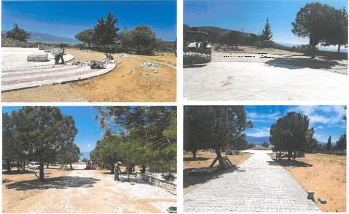
İlçemiz Kurtuluş (Bilara) Mahallesi, Cemiyet ve Mesire Alanı Beton Parke Döşeme Yapılması
