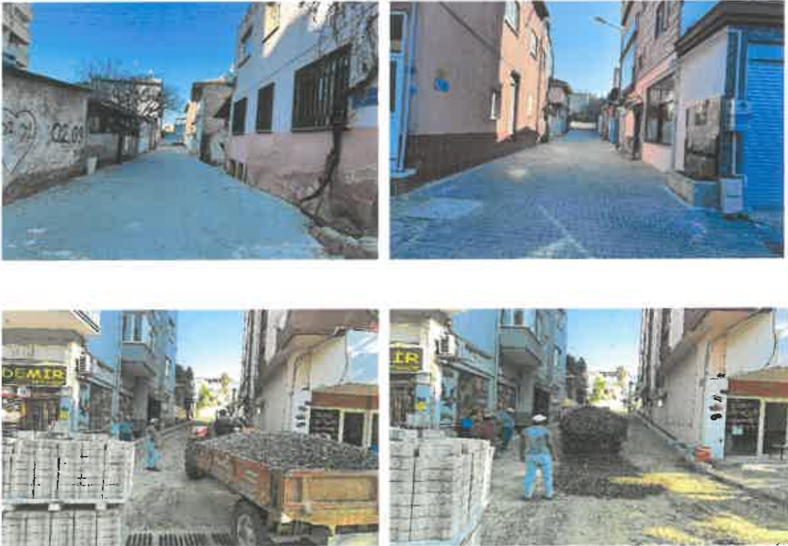
İlçemiz Cumhuriyet Mahallesi, Çömez ve Şahin Sokak Beton Parke Döşeme Yapılması
