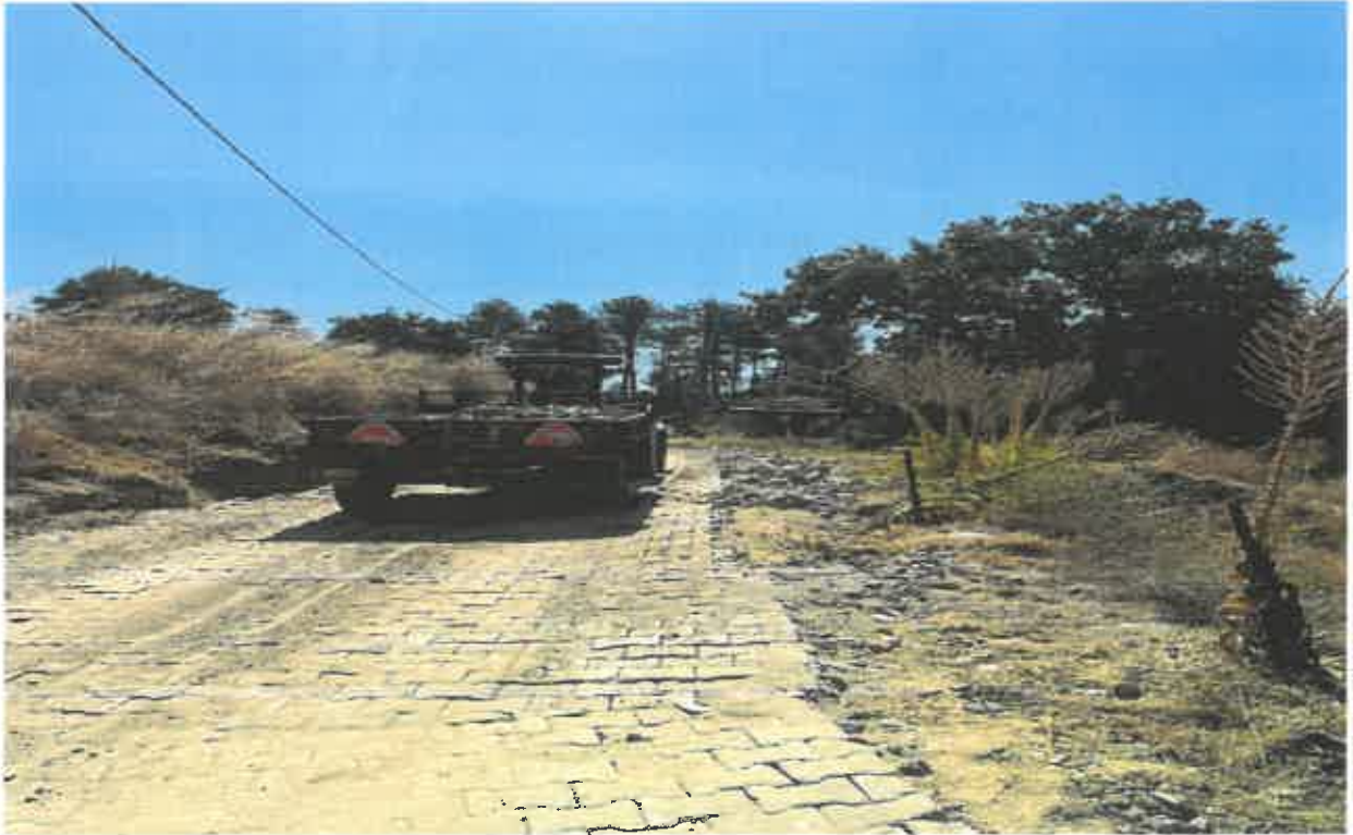
İlçemiz Musakolu Mahallesi Beton Parke Döşeme Yapılması
